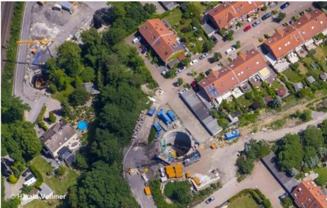
Luftbild der Baugruben im Bereich Hobestatt/Zeche Eiberg (Bild Privat, © H. Vollmer)
