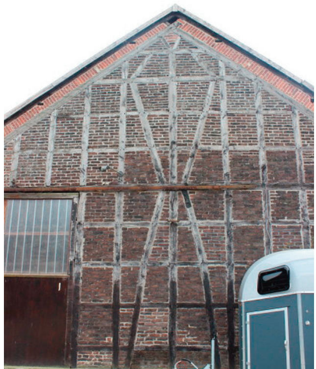
Links oben: der an der alten Scheune angebaute Göpel Oben: Fachwerk "Wilder Mann" an der Giebelseite der Scheune
