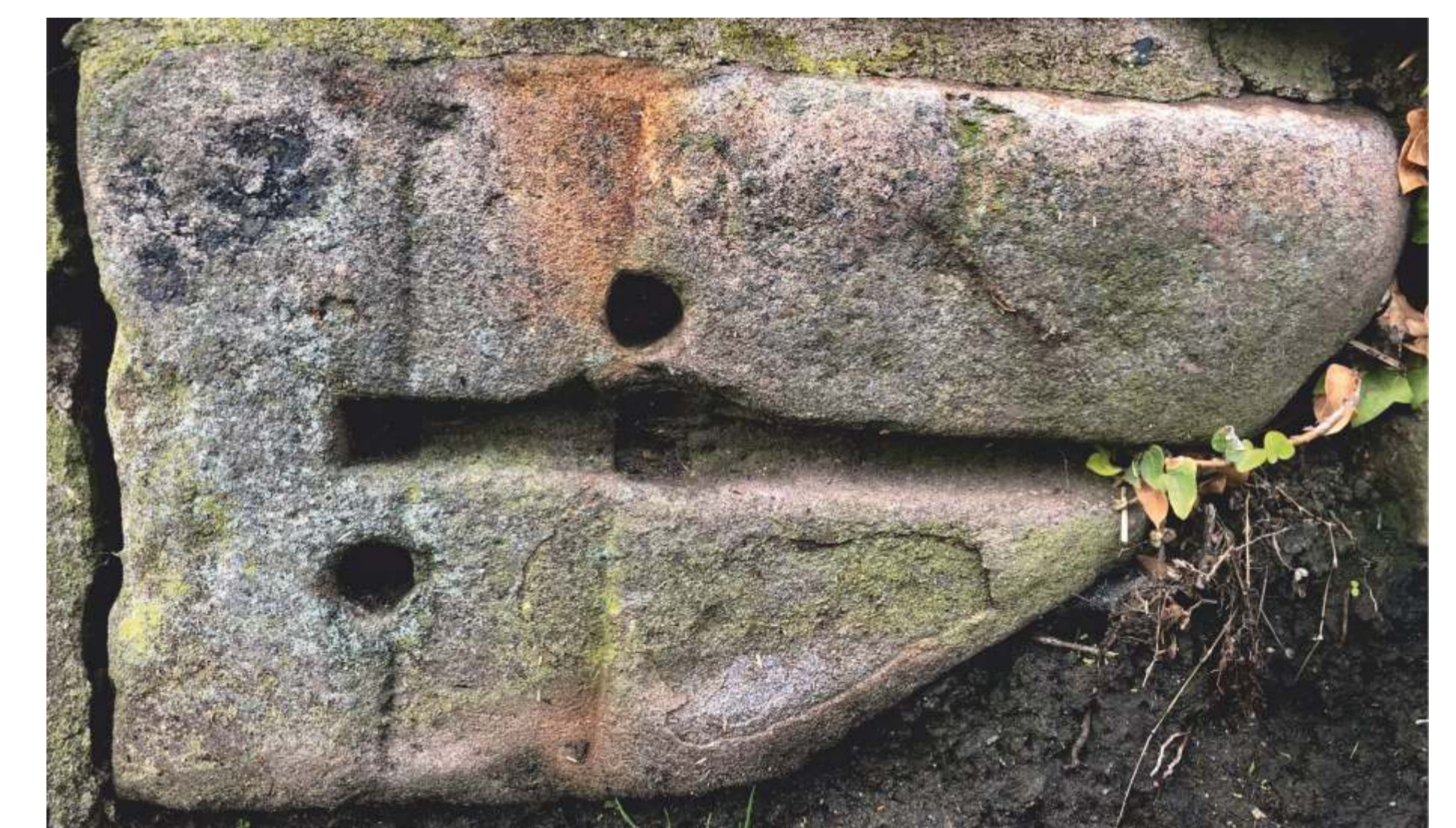
Alter Schwellenstein mit Löchern für die Dübel und die Ankerstange
